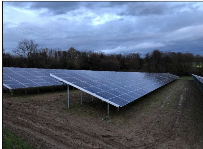
Abbildung 8: Beispiel Aufständering (Quelle: Fa. MKG Göbel)
